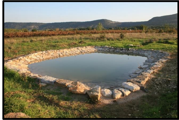
Mise en eau du bassin (pluies d'automne)
