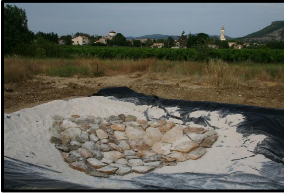
Mise en place du dallage
